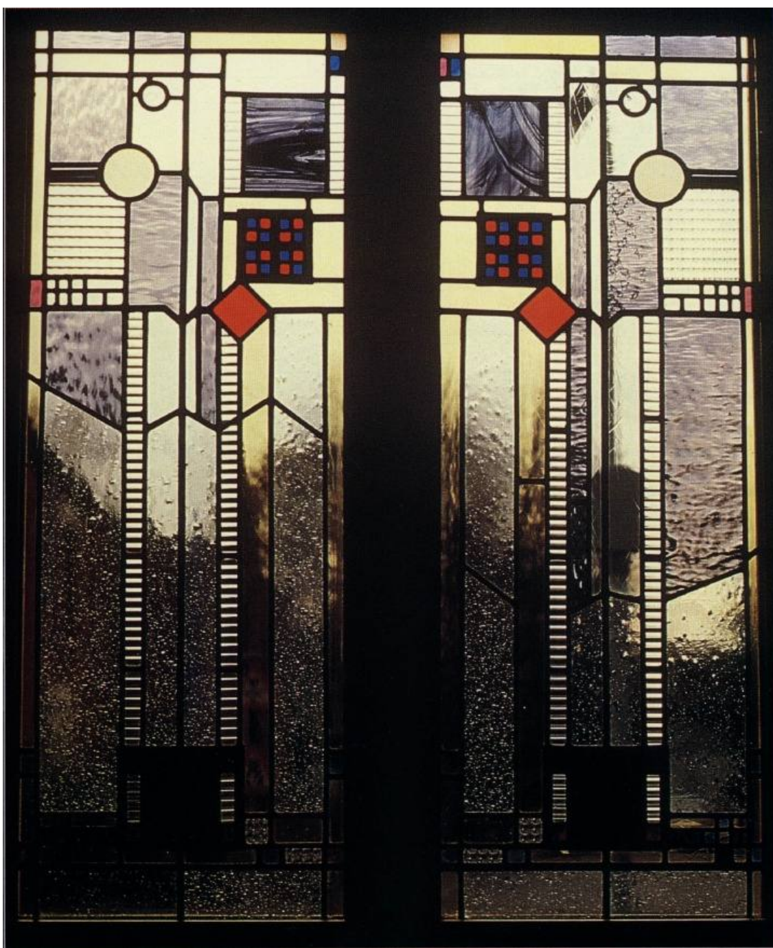
Acest vitraliu în plumb are peste 20 de tipuri de sticlă. MATHEW LLOYD WINDER
